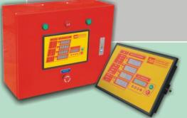
自动引水装置——当本产品采用低位水池的时候，可应用户要求增加优质可靠的自动引水装置，保证水泵及时起动、运行。
